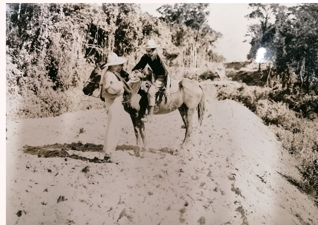
Trabajadores en la construcción del Ferrocarril del Sureste, 1939.
